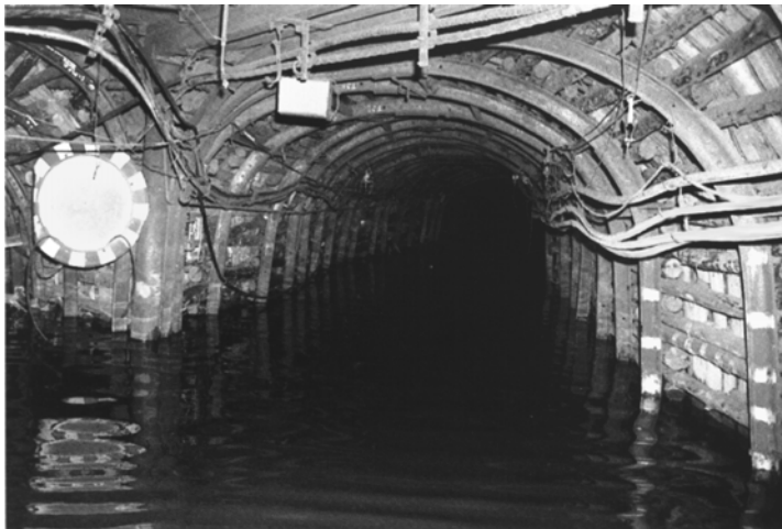
Abb. 87: Teilweise überfluteter Querschlag 1753 der Sohle -1305 Anfang Dezember 1992 im Bergwerk Niederschlema/Alberoda (aus BUNDESMINISTER FÜR WIRTSCHAFT 1993). Zu erkennen ist der Stahlbogenausbau einer zweigleisigen Strecke in der Bauart KSW 109-7124/02 mit Holzverzug aus Rundholz (SDAG WISMUT 1984). Ausbauhöhe der Strecke etwa 3 m, Wasserstand 0,5 m.
